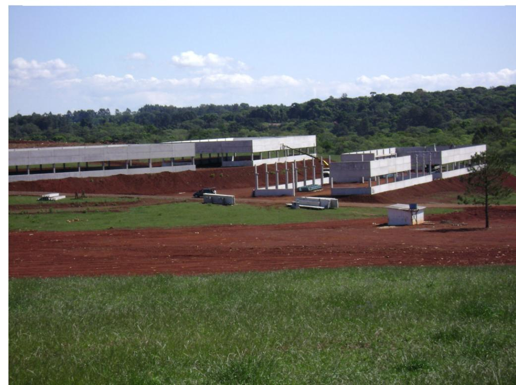
FOTO DOS LABORATÓRIOS (CHAPECÓ)- EXECUÇÃO DA ESTRUTURA PRÉ-MOLDADA
