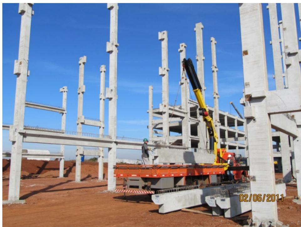
IMAGEM MONTAGEM DA ESTRUTURA EM CONCRETO PRÉ-MOLDADO
