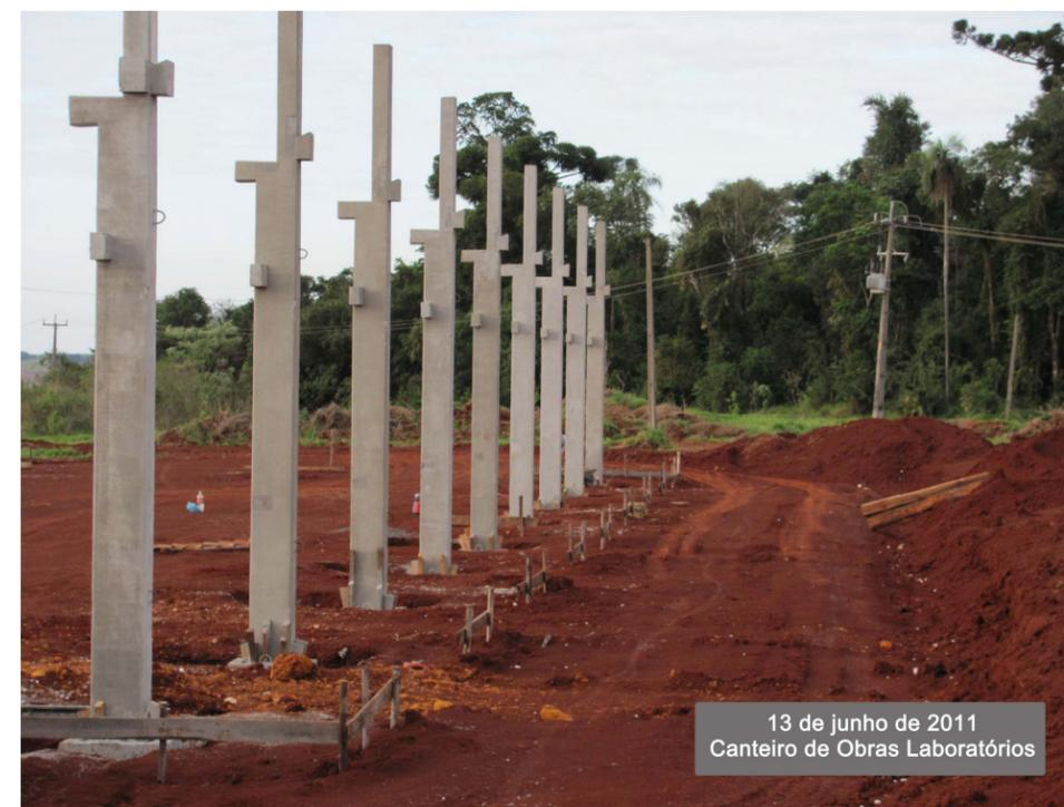
IMAGEM FUNDAÇÕES DA ESTRUTURA EM CONCRETO PRÉ-MOLDADO
